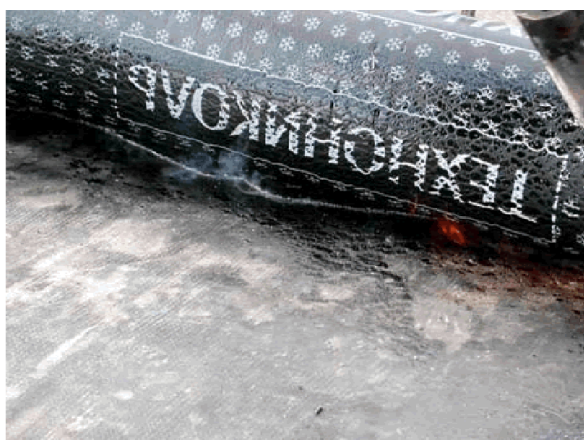
Фиг. 15. Вълничка от разтопено битумно свързващо вещество.
