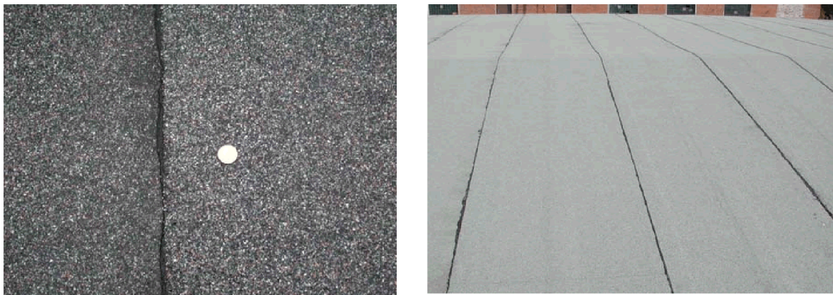
Фиг. 16. Битумно свързващо вещество, изтекло изпод ръба на материала. (за сравнение монета от 10 ст.)
